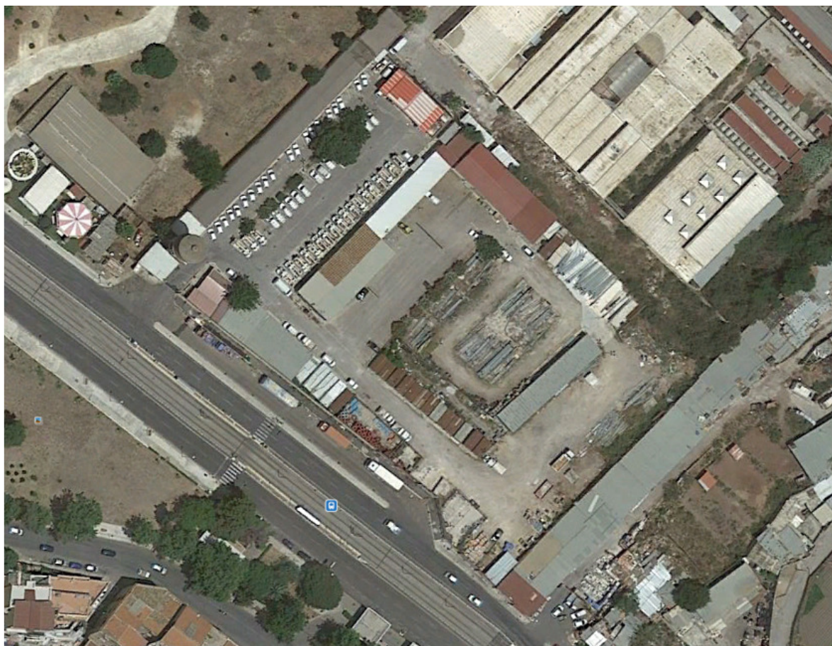
Vista aerea area pubblica Illuminazione AMG Energia S.p.a.
